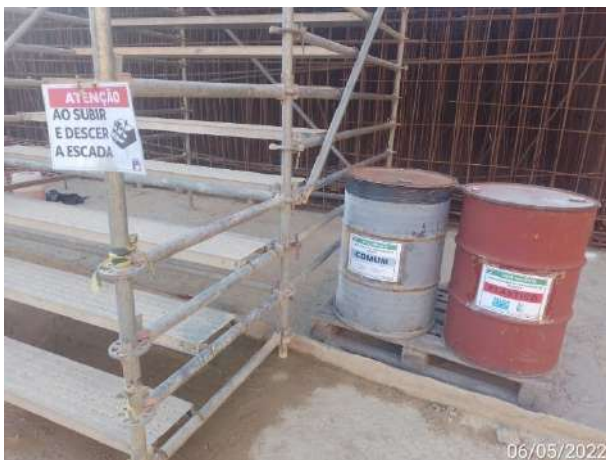
Foto 273 – Troca de caçambas de resíduo comum no canteiro operacional. (Data:06/05/2022)
