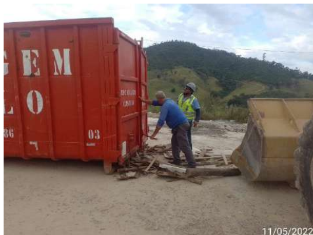
Foto 71 – Limpeza e organização dos resíduos de madeira na frente de serviço. (Data:11/05/2022)
