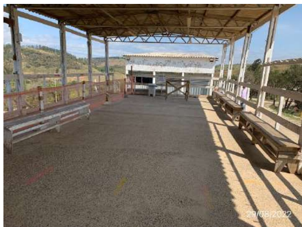
Foto 99 – Limpeza e organização na área de Vivência do Canteiro Industrial. (Data:29/08/2022).
