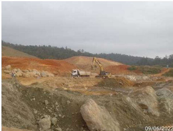
Foto 293 – Limpeza rigorosa margem direita. (Data:09/06/2022)
