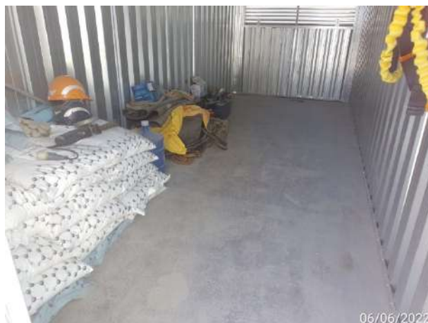
Foto 84 – Limpeza e organização no container utilizado para depósito de materiais. (Data:06/06/2022).
