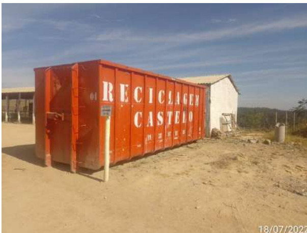
Foto 279 – Caçamba para resíduos de madeira disponível na frente de serviço. (Data:18/07/2022)
