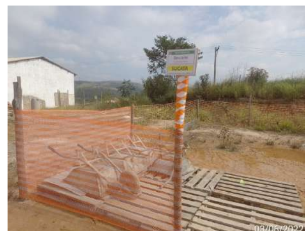
Foto 80 – Limpeza e organização no canteiro industrial. (Data:03/06/2022).
