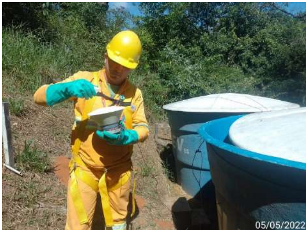
Foto 102 – Adequação de dosagem de cloro na caixa de água. (Data:05/05/2022)
