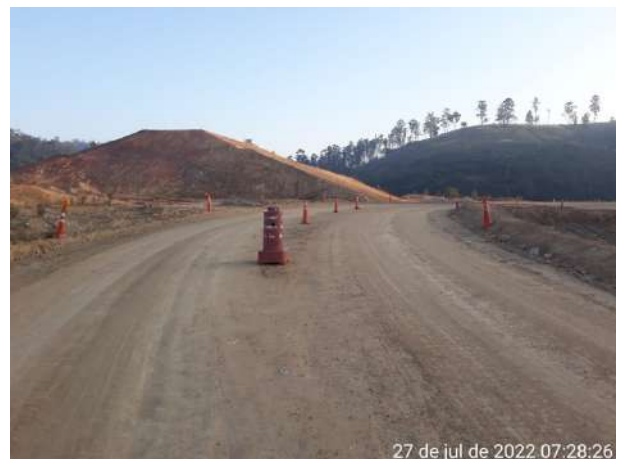
Foto 196 – Sinalização vertical implantada em via interna. (Data: 27/07/2022)
