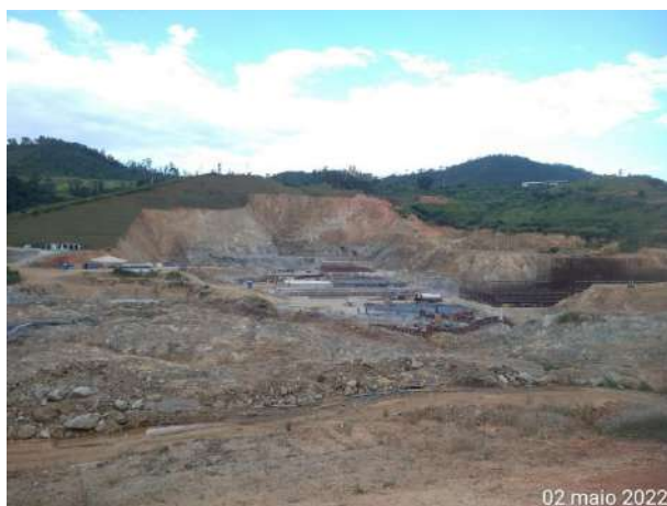
Foto 287 – Limpeza rigorosa margem direita. (Data:02/05/2022)
