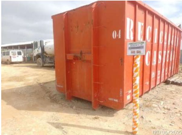
Foto 275 – Caçamba para resíduos de madeira disponível na frente de serviço. (Data:03/06/2022)
