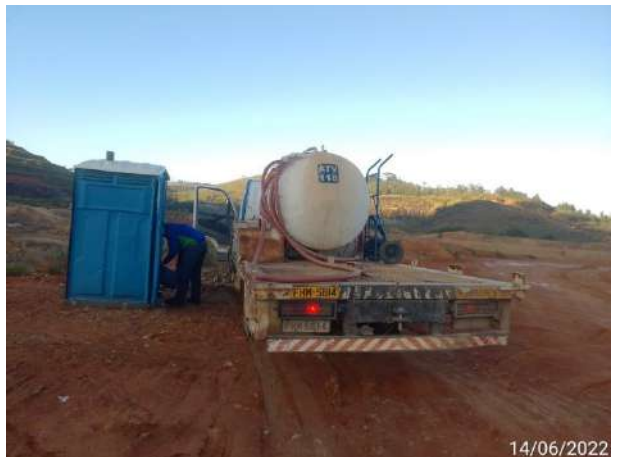
Foto 236 – Registro de higienização de banheiro químico na frente de serviço. (Data:14/06/2022)
