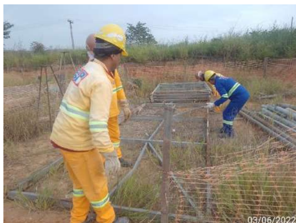
Foto 81 – Limpeza e organização no canteiro industrial. (Data:03/06/2022).
