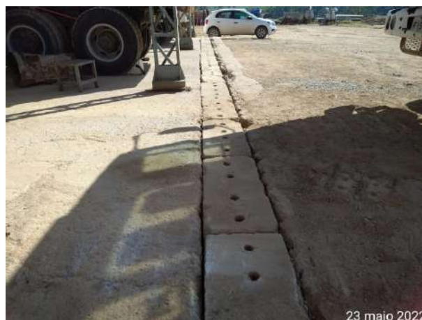
Foto 218 – Canaleta de drenagem e contenção na Área da Oficina Mecânica. (Data:23/05/2022)
