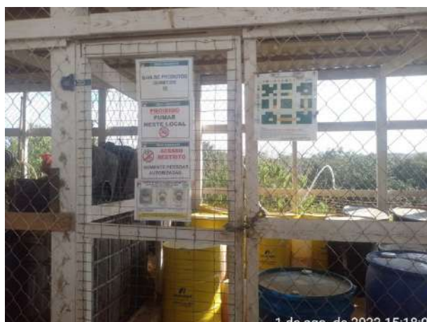
Foto 43 - Vista geral da baía de armazenamento de Produtos Perigosos na Oficina Mecânica. (Data:01/08/2022)
