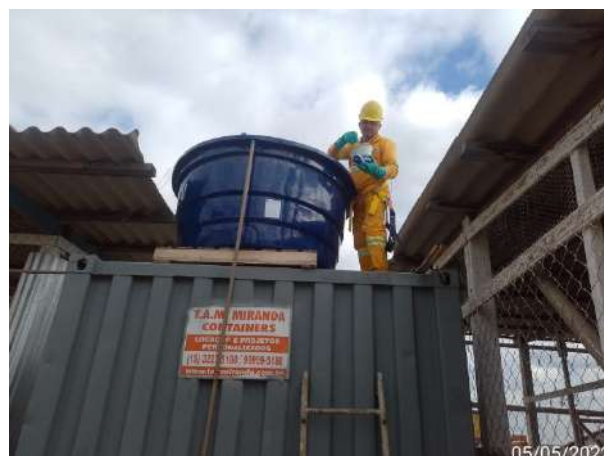
Foto 104 – Adequação de dosagem de cloro na caixa de água. (Data:05/05/2022)
