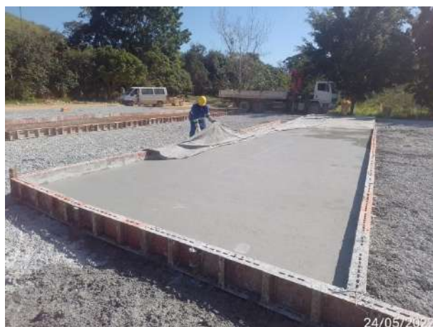
Foto 76 – Vista da área organizada para fabricação do Pré-Moldado. (Data:24/05/2022)
