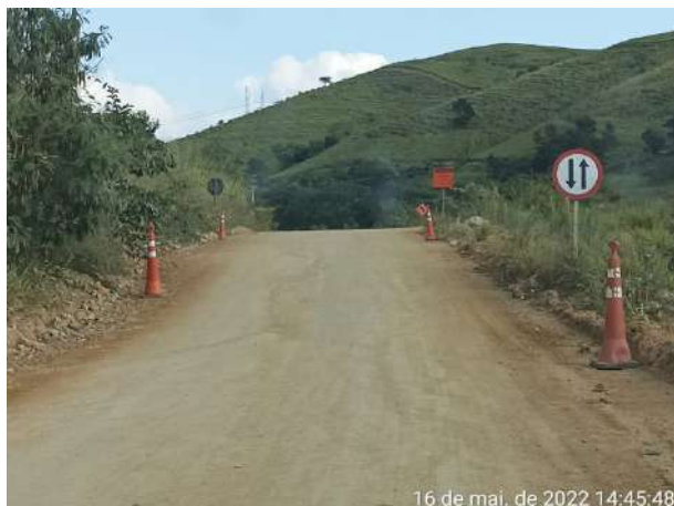
Foto 187 – Sinalização vertical implantada em via interna. (Data:16/05/2022)
