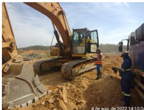
Foto 138 – Escavadeira Hidráulica inspecionada na frente de serviço. (Data:04/08/2022)
