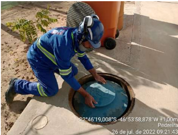
Foto 221 – Limpeza do sistema de tratamento de efluentes do Posto de abastecimento no canteiro industrial. (Data:26/07/2022)
