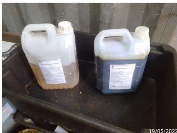
Foto 34 – Galões rotulados dispostos na frente de serviço em bandeja de contenção. (Data:19/05/2022)
