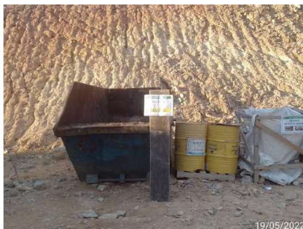
Foto 74 – Recipientes disponibilizados nas frentes de serviços em apoio nas atividades Limpeza e organização no canteiro operacional. (Data:19/05/2022)
