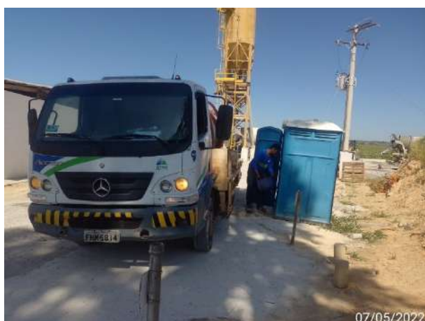
Foto 225 – Registro de higienização de banheiro químico na frente de serviço. (Data:07/05/2022)
