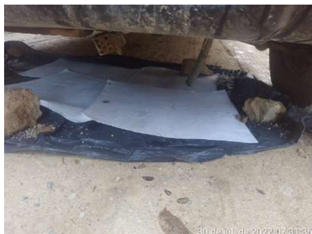
Foto 61 – Proteção realizada com lona plástica e manda absorvente para proteção do solo na frente de serviço. (Data:30/07/2022)
