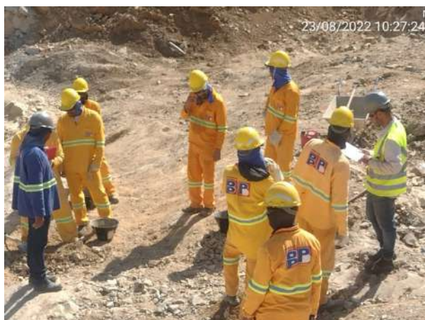
Foto 167 – Treinamento da APR de Limpeza de Rochas e Detritos realizado na frente de serviço. (Data:23/08/2022)
