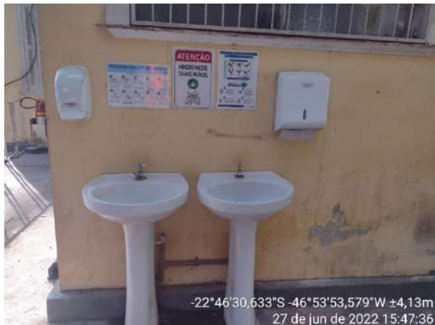
Foto 147 – Pias para higienização das mãos no canteiro administrativo. (Data:27/06/2022).
