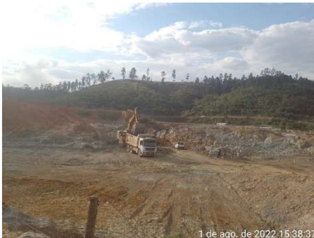
Foto 299 – Limpeza rigorosa na fundação. (Data:01/08/2022)
