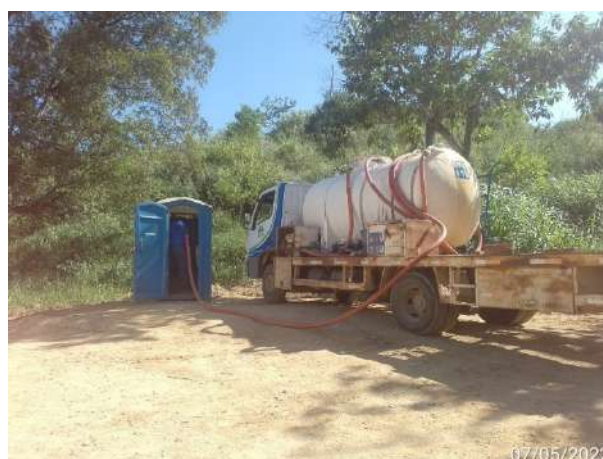
Foto 226 – Registro de higienização de banheiro químico na frente de serviço. (Data:07/05/2022)
