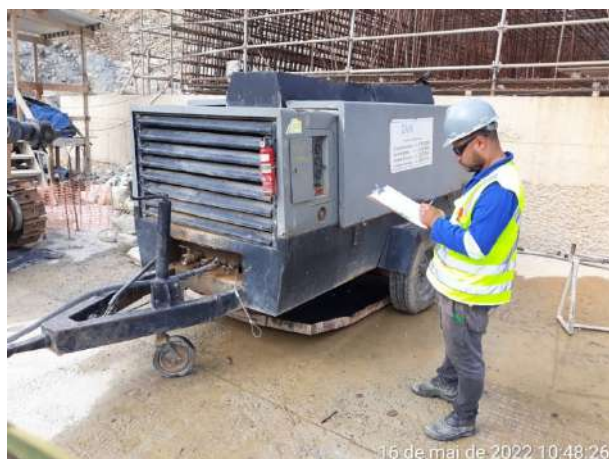
Foto 127 – Realização de inspeção em gerador na frente de serviço. (Data:16/05/2022)
