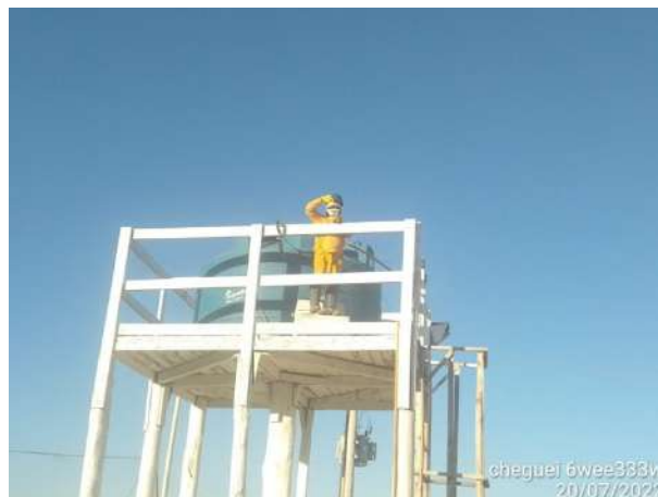
Foto 110 – Adequação de dosagem de cloro na caixa de água disposta na frente de serviço. (Data:20/07/2022)
