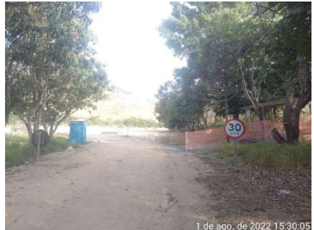
Foto 198 – Sinalização vertical implantada em via interna. (Data:01/08/2022)
