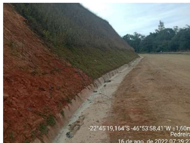
Foto 212 – Sistema de drenagem sarjeta nas vias do empreendimento. (Data:16/08/2022)
