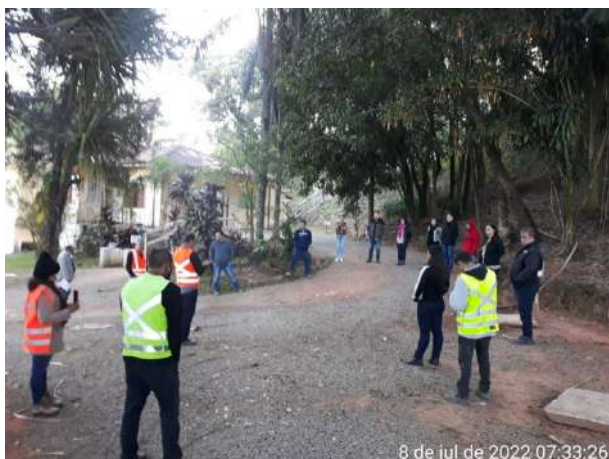
Foto 181 – DDS realizado com as equipes na frente de serviço. (Data:08/07/2022).
