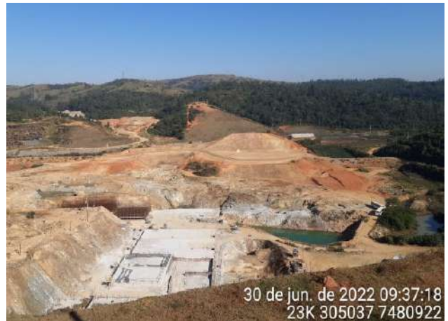
Foto 294 – Vista geral das obras do eixo e dos botaforas. (Data:30/06/2022)
