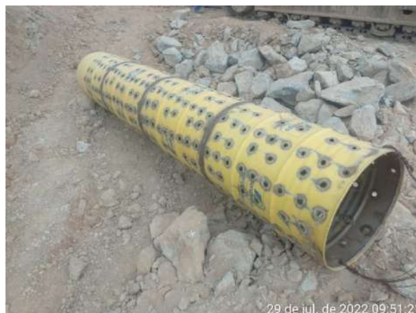
Foto 122 – Reutilização de tambores para drenar água de poços na frente de serviço Data:29/07/2022)
