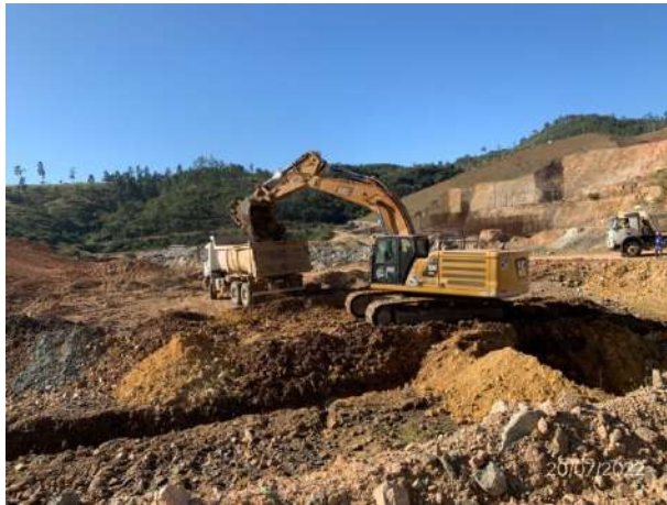
Foto 297 – Limpeza rigorosa margem direita. (Data:20/07/2022)
