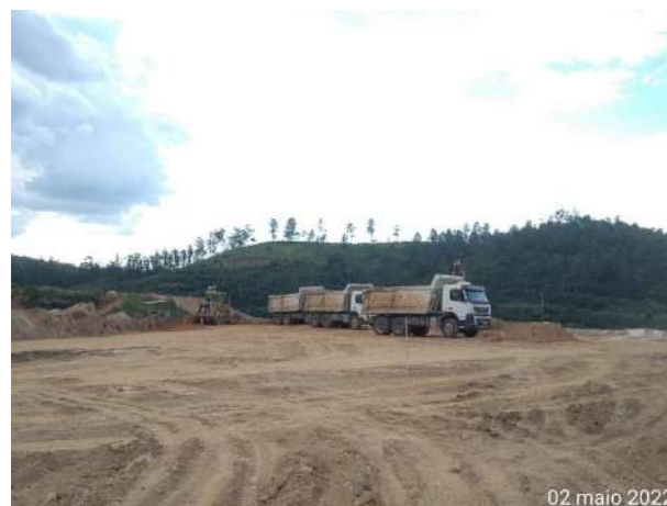
Foto 288 – Limpeza rigorosa margem direita. (Data:02/05/2022)
