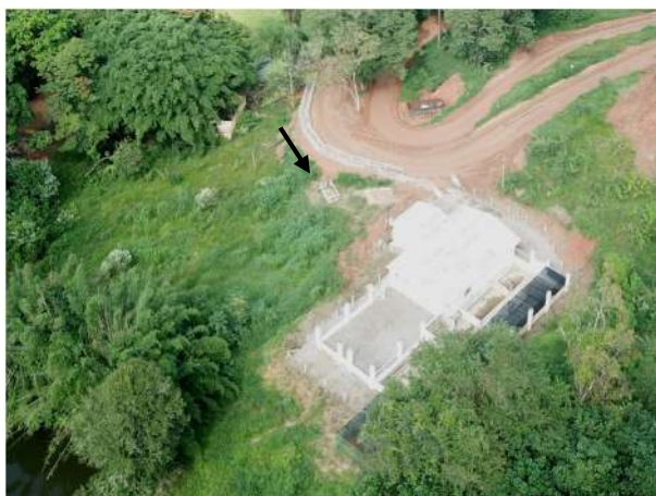
Foto 247 – Localização do Biodigestor 03 na base de fauna.
