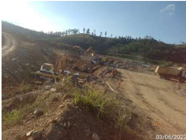
Foto 291 – Limpeza rigorosa margem direita. (Data:03/06/2022)
