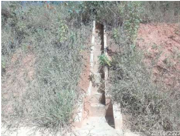
Foto 205 – Sistema de drenagem implantado em talude de corte - MD03. (Data:23/06/2022)
