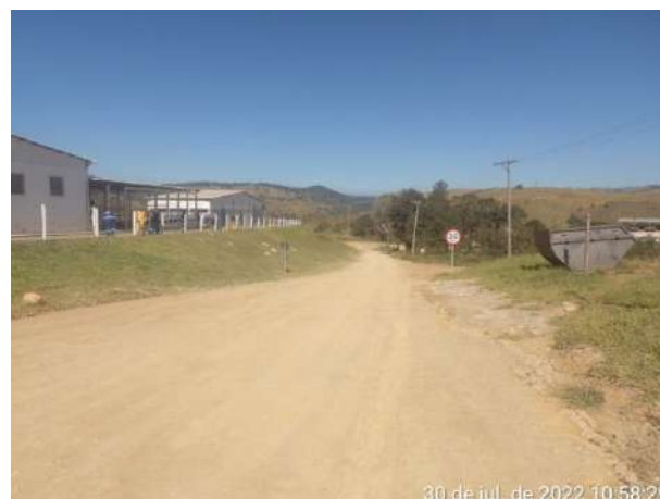
Foto 90 – Limpeza e organização na área externa do canteiro industrial. (Data:30/07/2022).
