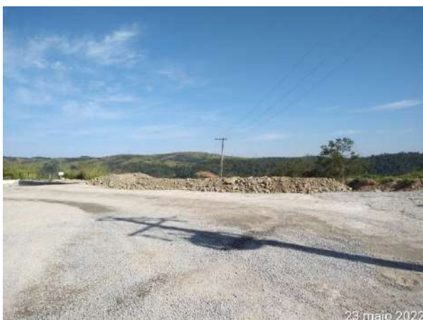
Foto 203 – Leira implantada para contenção e disciplinamento de águas pluviais - Usina. (Data:23/05/2022)
