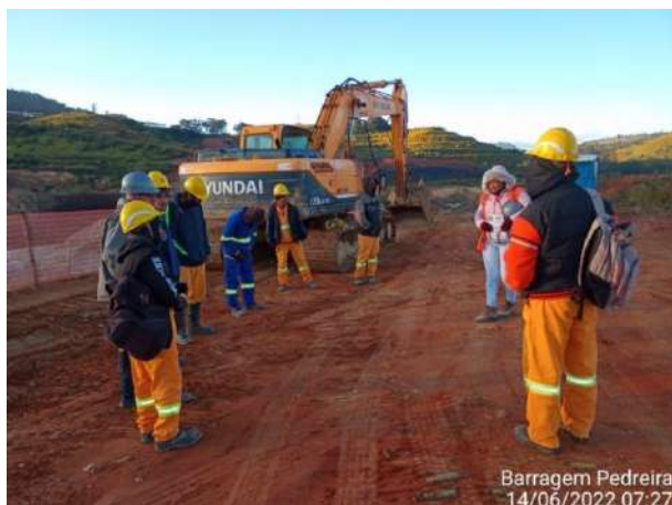
Foto 159 – Treinamento de APR de Limpeza de Rochas e Detritos realizados na frente de serviço (Data:14/06/2022)
