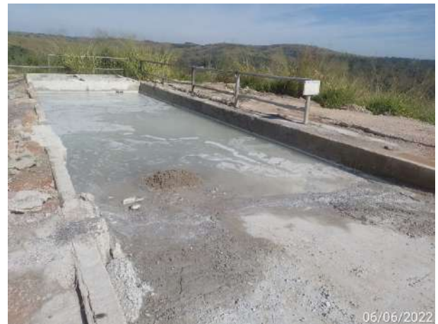
Foto 220 – Área destinada para lavagens de bicas de caminhão betoneira no canteiro industrial. (Data:06/06/2022)
