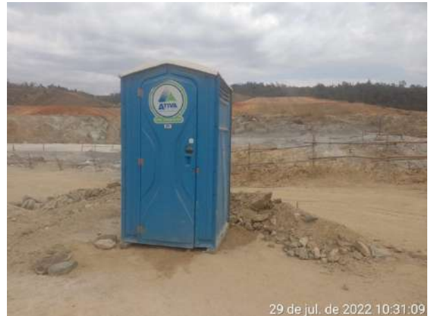
Foto 240 – Vista do banheiro químico disposto na frente de serviço. (Data:29/07/2022).
