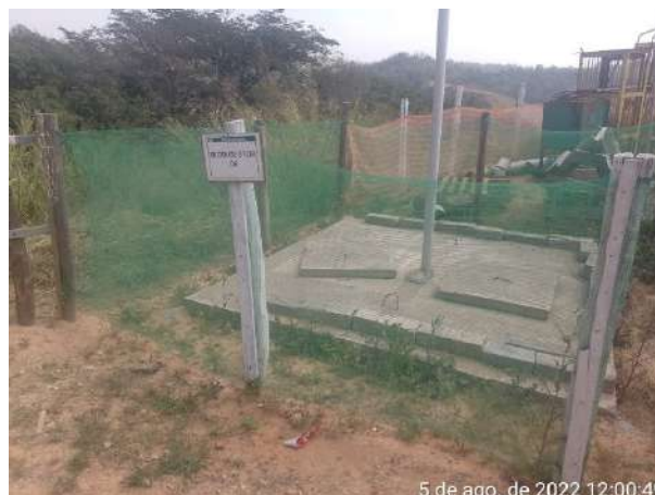
Foto 248 – Biodigestor 04 no canteiro industrial. (Data:05/08/2022)
