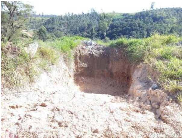
Foto 201 – Limpeza de cacimba de decantação na frente de serviço – Usina. (Data:23/05/2022)
