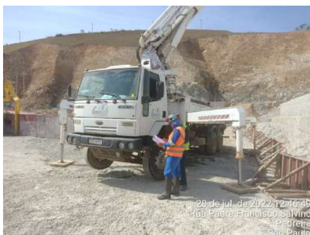
Foto 136 – Caminhão Bomba Lança (CONCRERETI) inspecionado na frente de serviço. (Data:28/07/2022)
