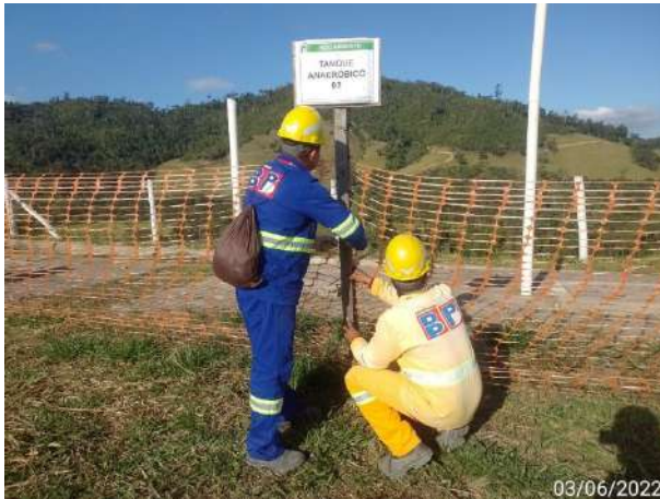
Foto 233 – Adequação das placas de identificação do Tanque Anaeróbico 2. (Data:03/06/2022).
