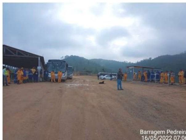
Foto 178 – DDS realizado com as equipes na frente de serviço. (Data:16/05/2022)
