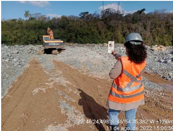
Foto 261 – Medição de fumaça preta em máquina retroescavadeira. (Data:11/08/2022)
