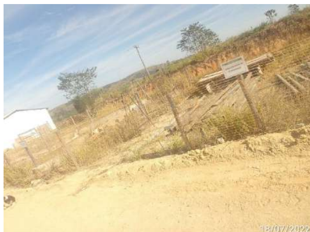
Foto 87 – Baías destinadas para depósito de materiais temporários – Canteiro Industrial. (Data:18/07/2022).
