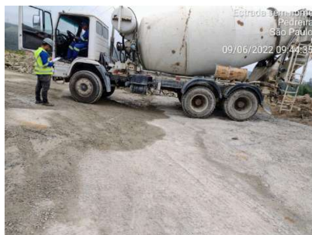
Foto 129 – Caminhão Betoneira inspecionado na frente de serviço. (Data:09/06/2022)
