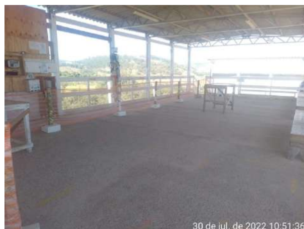
Foto 89 – Limpeza e organização na área de Vivência do Canteiro Industrial. (Data:30/07/2022).
