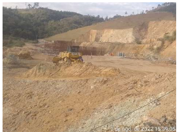
Foto 300 – Limpeza na fundação. (Data:01/08/2022)
