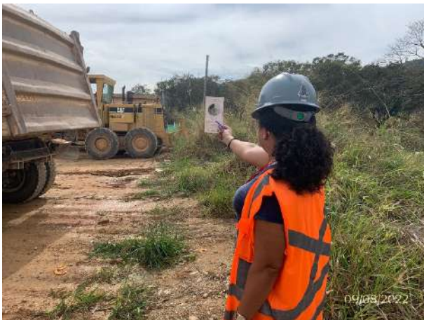
Foto 259 – Medição de fumaça preta em máquina patrol. (Data:09/08/2022)
