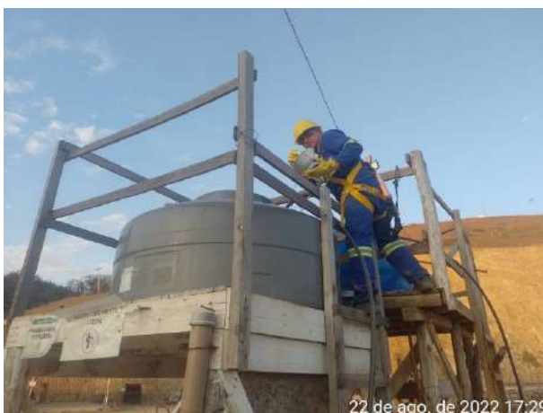
Foto 114 – Adequação de dosagem de cloro na caixa de água disposta na frente de serviço. (Data:22/08/2022)
