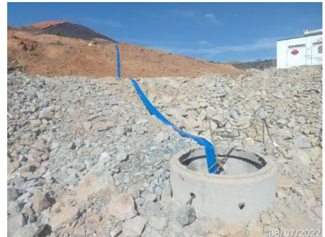
Foto 208 – Limpeza de cacimba de decantação no frente de serviço – Usina. (Data:08/07/2022)
