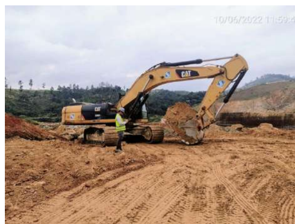
Foto 130 – Escavadeira Hidráulica inspecionada na frente de serviço. (Data:10/06/2022)
