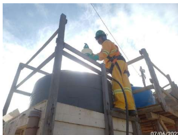
Foto 106 – Adequação de dosagem de cloro na caixa de água disposta na frente de serviço. (Data:07/06/2022)
