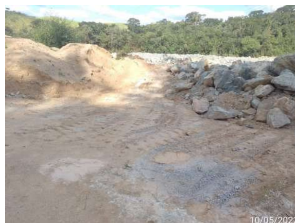
Foto 290 – Área de bota-fora utilizado para descarte de materiais. (Data:10/05/2022)
