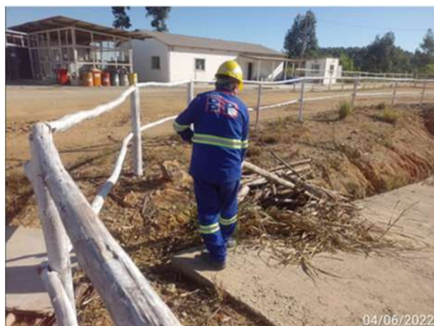
Foto 83 – Limpeza e organização no canteiro industrial. (Data:04/06/2022).
