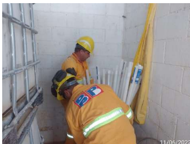
Foto 38 – Vista dos colaboradores realizando a organização dos descartes das lâmpadas fluorescentes tubulares na baía. (Data:11/06/2022)
