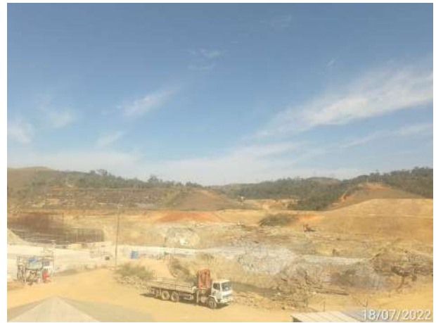
Foto 298 – Vista geral das áreas de intervenção na margem direita (Data:18/07/2022)
