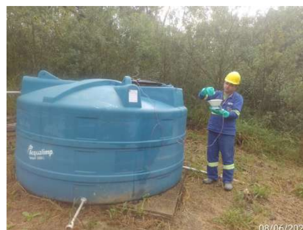
Foto 108 – Adequação de dosagem de cloro na caixa de água disposta na frente de serviço. (Data:08/06/2022)
