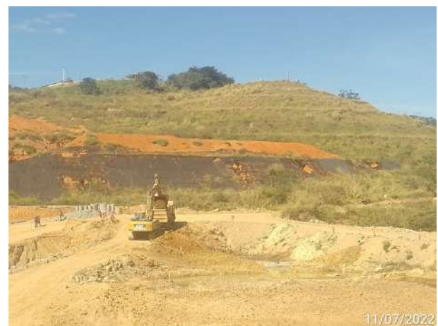
Foto 296 – Limpeza rigorosa margem direita. (Data:11/07/2022)
