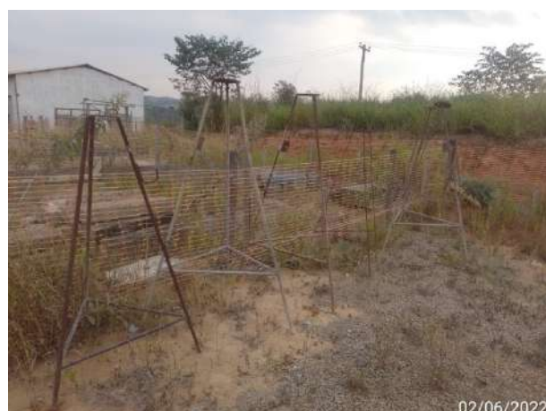
Foto 79 – Limpeza e organização realizada no canteiro industrial. (Data:02/06/2022).
