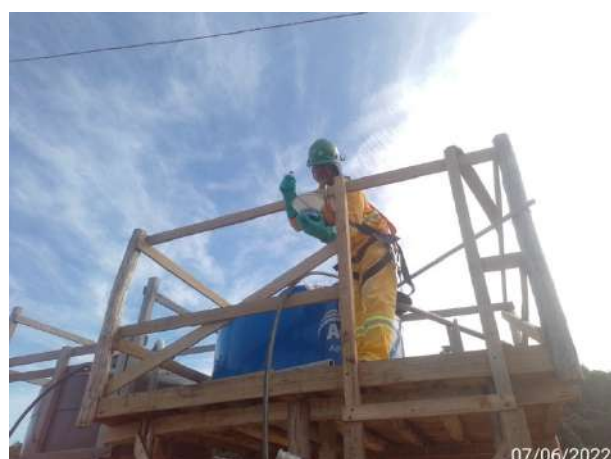
Foto 107 – Adequação de dosagem de cloro na caixa de água disposta na frente de serviço. (Data:07/06/2022)
