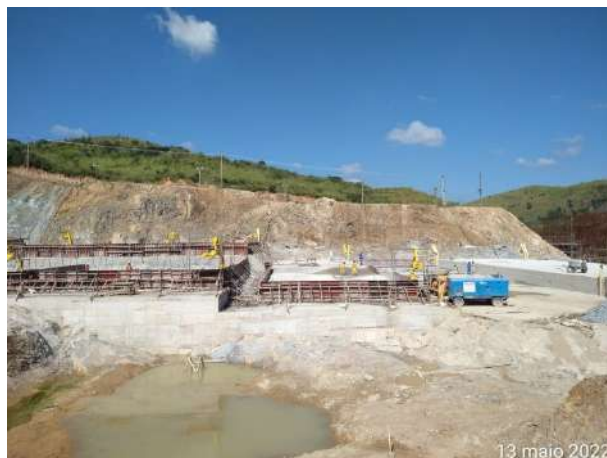
Foto 72 – Vista geral da área da fundação limpa e organizada. (Data:13/05/2022)
