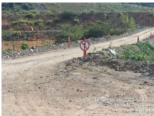
Foto 185 – Sinalização vertical implantada em via interna. (Data:16/05/2022)
