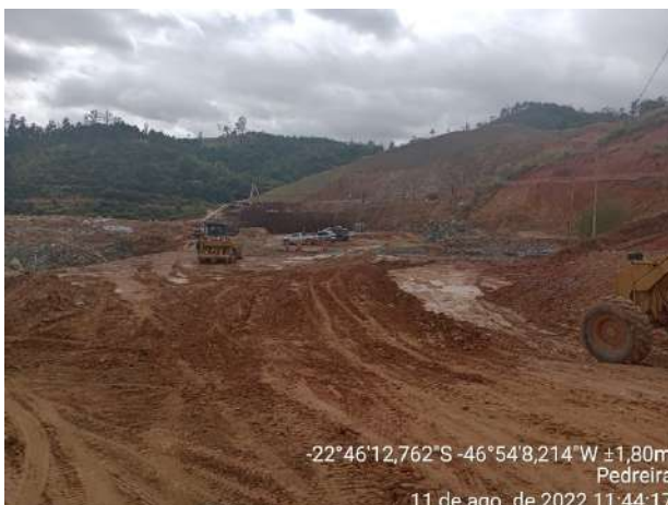
Foto 301 – Limpeza rigorosa na fundação. (Data:11/08/2022)
