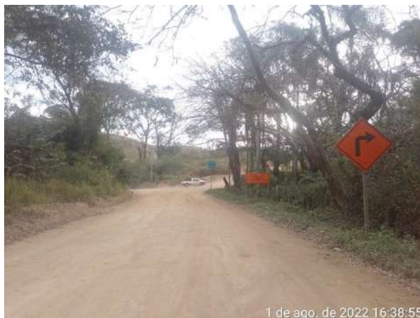
Foto 199 – Sinalização vertical implantada em via interna. (Data:01/08/2022)
