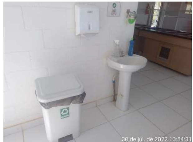
Foto 150 – Lavatório provido de sabão e álcool em gel no refeitório do canteiro administrativo. (Data:30/07/2022).
