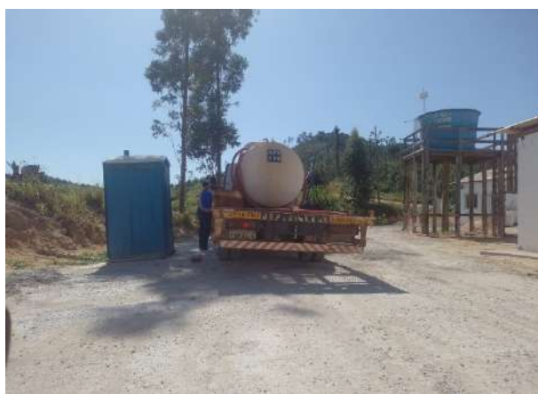
Foto 227 – Registro de higienização de banheiro químico na frente de serviço. (Data:07/05/2022)
