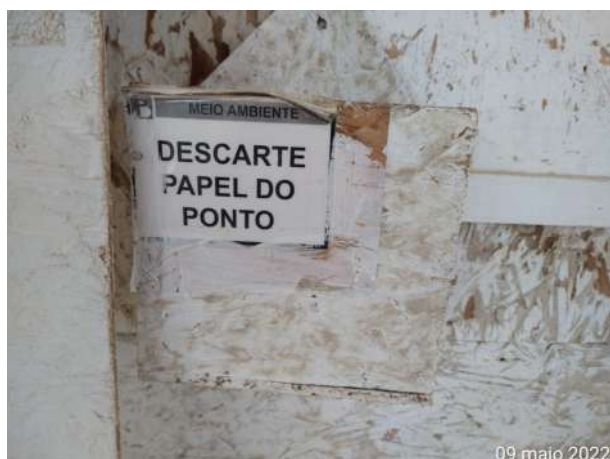
Foto 69 – Caixa de descarte de papel ponto disposto na frente de serviço. (Data:09/05/2022)
