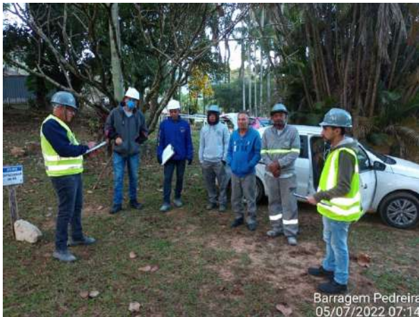
Foto 161 – Treinamento da APR de Injeção (Resina de poliuretano estrutural lento) realizados na frente de serviço (Data:05/07/2022)
