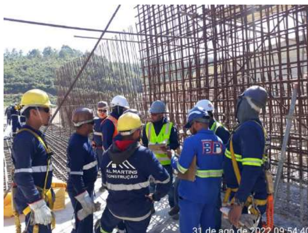
Foto 168 – Treinamento da APR de Montagem de Armação realizado na frente de serviço (Data:31/08/2022)
