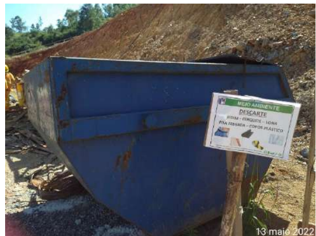
Foto 274 – Coletores de resíduos recicláveis disponíveis no canteiro administrativo. (Data:13/05/2022)
