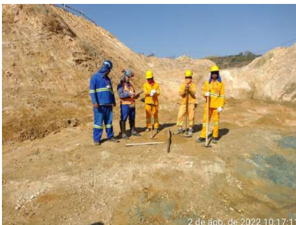
Foto 165 – Treinamento da APR de Limpeza de Rochas e Detritos realizado na frente de serviço. (Data:02/08/2022)
