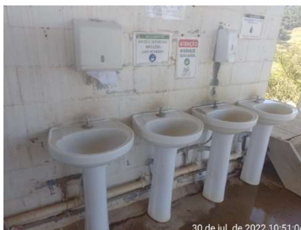
Foto 91 – Limpeza e organização realizada no canteiro industrial. (Data: 30/07/2022).
