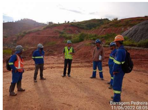
Foto 158 – Treinamento de APR (Terraplanagem) realizado na frente de serviço. (Data:11/06/2022)
