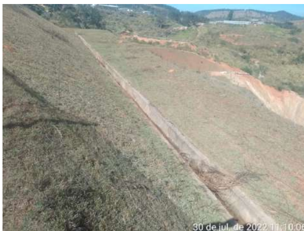
Foto 209 – Sistema de drenagem implantado em talude na Ombreira Direita. (Data:30/07/2022)
