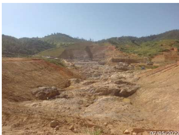
Foto 289 – Limpeza rigorosa margem direita. (Data:07/05/2022)
