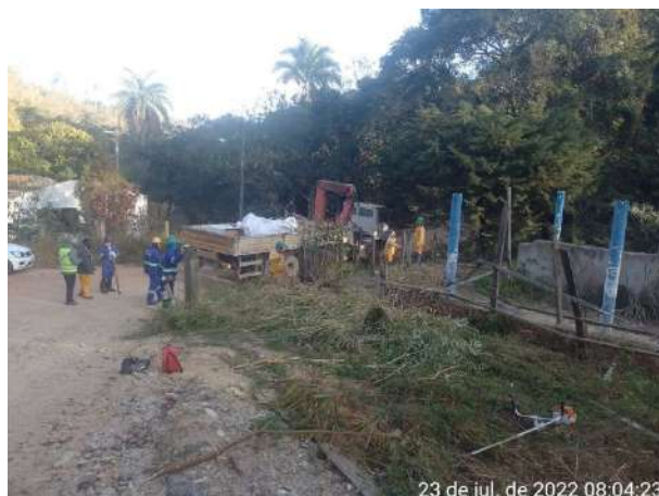
Foto 88 – Limpeza e organização realizada no canteiro industrial. (Data: 23/07/2022).
