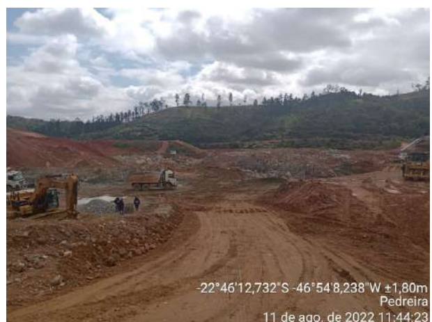
Foto 302 – Limpeza rigorosa na fundação. (Data:11/08/2022)
