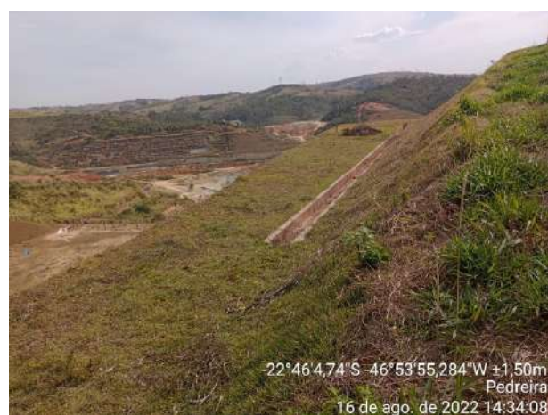
Foto 214 – Sistema de drenagem implantado em talude na Ombreira Direita. (Data:16/08/2022)
