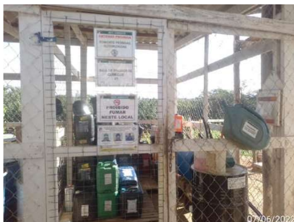
Foto 36 – Vista geral da baía de armazenamento de Produtos Perigos na Oficina Mecânica. (Data:07/06/2022)
