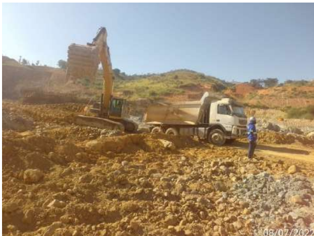
Foto 295 – Limpeza rigorosa margem direita. (Data:08/07/2022)
