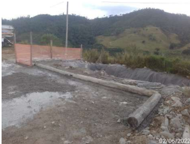
Foto 219 – Área para lavagem de calha de betoneira no canteiro industrial. (Data:02/06/2022)
