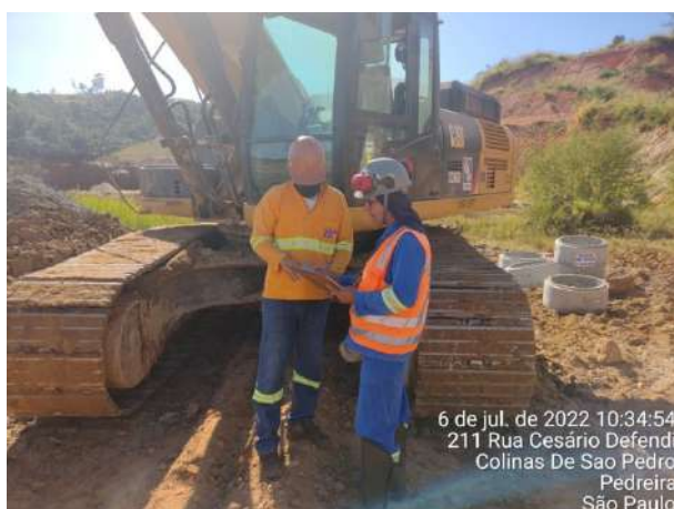
Foto 134 – Escavadeira Hidráulica inspecionada na frente de serviço. (Data:06/07/2022)
