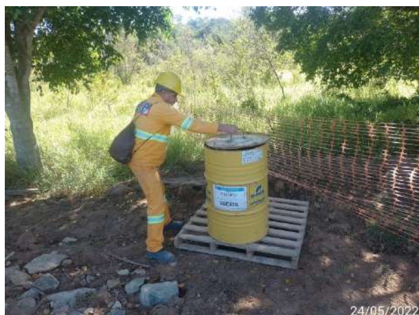
Foto 75 – Limpeza e organização no canteiro administrativo. (Data:24/05/2022)
