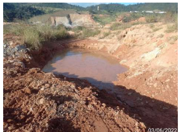
Foto 204 – Limpeza de cacimba de decantação na frente de serviço – Usina. (Data:03/06/2022)
