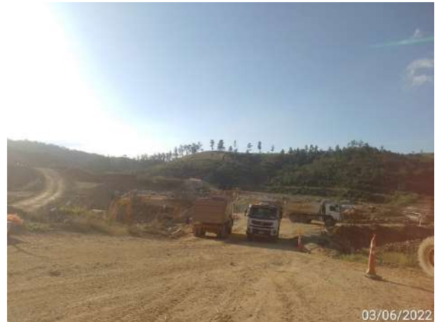
Foto 292 – Limpeza rigorosa margem direita. (Data:03/06/2022)
