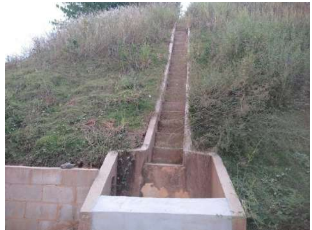
Foto 202 – Sistema de drenagem implantado em talude de corte - MD03. (Data:02/05/2022)
