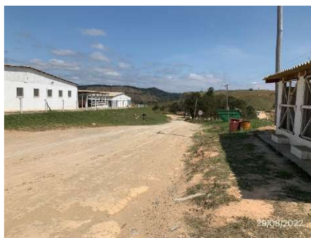
Foto 100 – Limpeza e organização na área externa do canteiro industrial. (Data:29/08/2022).
