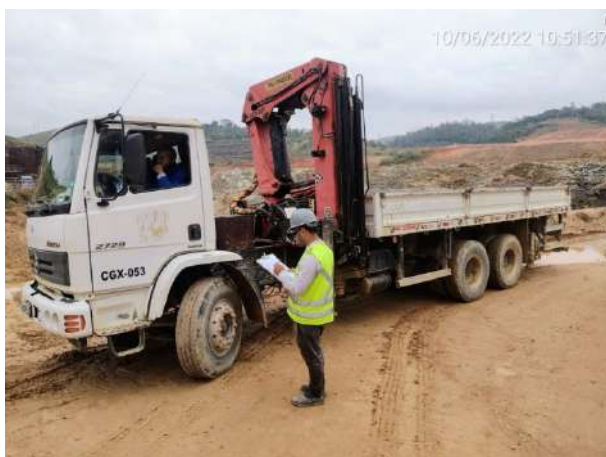
Foto 131 – Caminhão Guindauto inspecionado na frente de serviço. (Data:10/06/2022)
