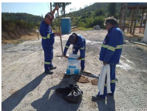
Foto 51 – Limpeza de pequeno vazamento ocorrido na frente de serviço. (Data:23/05/2022)
