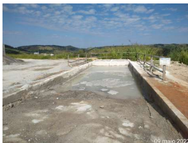
Foto 216 – Área para lavagem de calha de betoneira – usina de concreto. (Data:09/05/2022)
