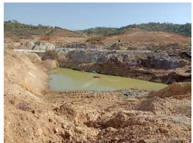
Foto 210 – Sistema de drenagem provisória com bomba implantada no poço na frente de serviço. (Data:19/07/2022)
