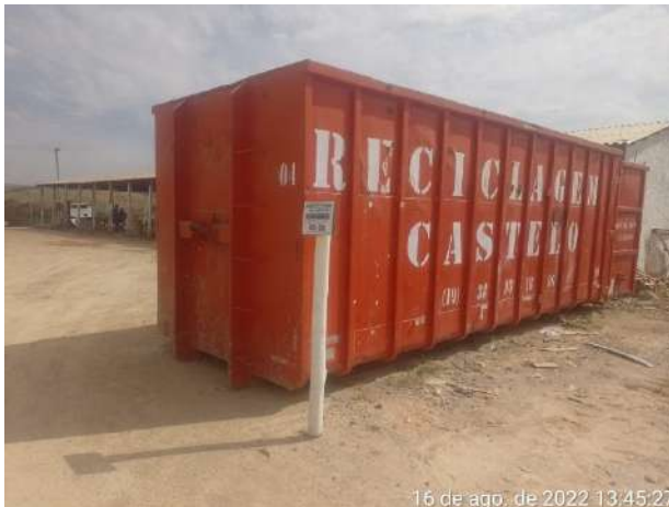
Foto 283 – Caçamba para resíduos de madeira disponível na frente de serviço. (Data:16/08/2022)
