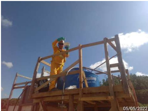
Foto 101 – Adequação de dosagem de cloro na caixa de água. (Data:05/05/2022)
