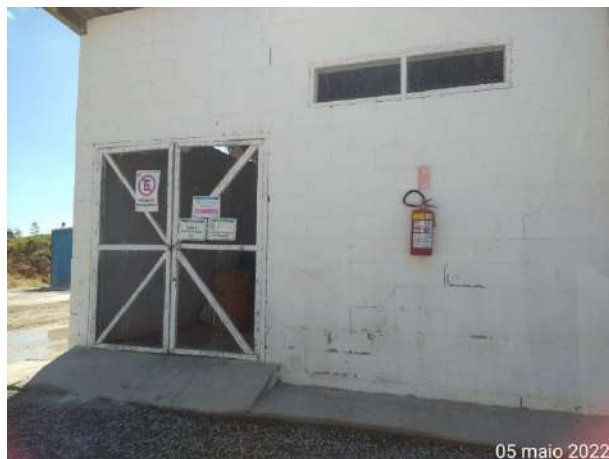
Foto 29 – Baía de produtos químicos no pátio da Usina de Concreto. (Data:05/05/2022)
