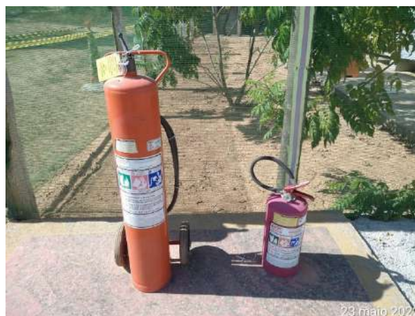
Foto 128 – Extintores de incêndio inspecionados na frente de serviço. (Data:23/05/2022)
