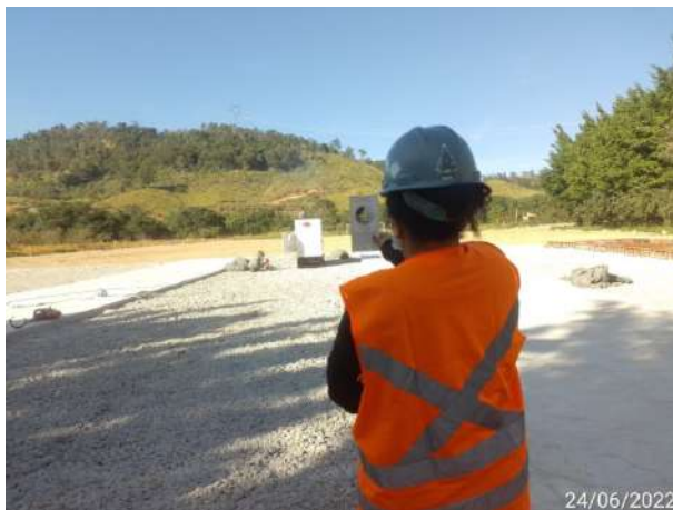
Foto 257 – Medição de fumaça preta em gerador na frente de serviço. (Data:24/06/2022)
